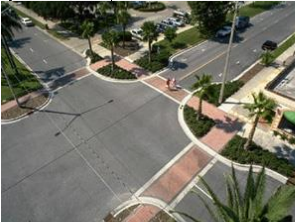
Figura 82 – Estreitamento de pista
